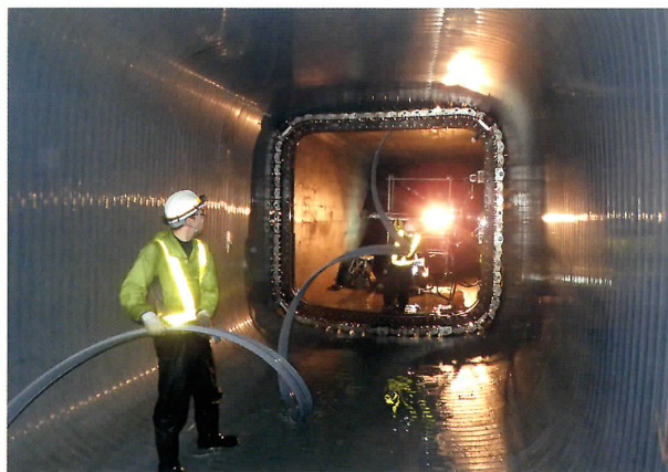
SPR工法による排水管補強工事
