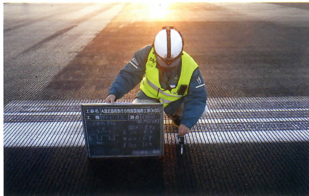
グルーピングの補修工事
